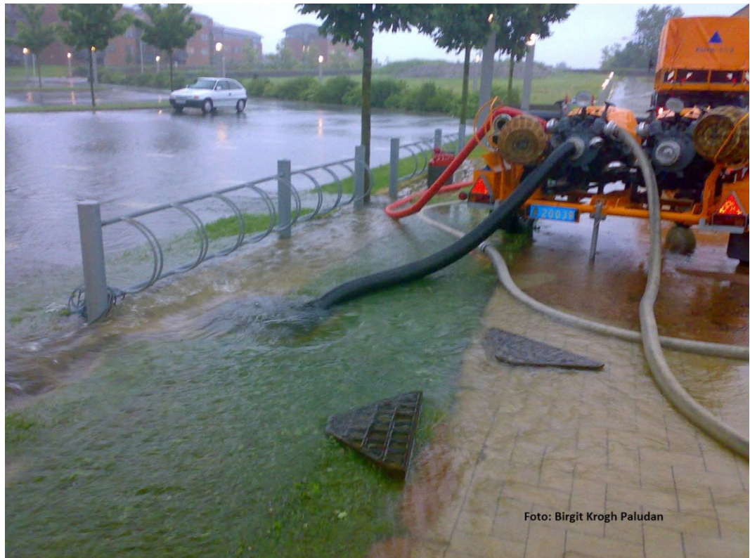
Figur 9.4 Mobilpumpe anvendt ved Greve Gymnasium under ekstremnedbøren i Greve 5. juli 2010.
