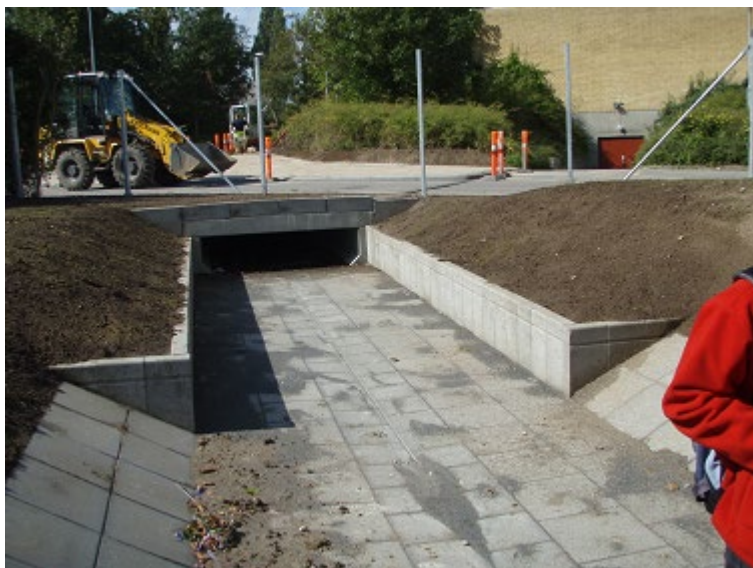
Figur 7.2 Aflastningskanal til reduktion af oversvømmelser ved Idrætsparken i Odense, etableret i 2008. Se appendiks C.
