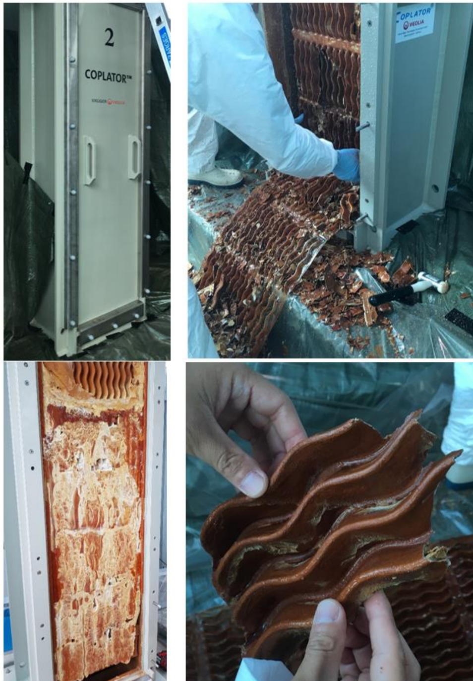
Figur 3 Rengøring af coplators efter et års drift på Brøndbyvester vandværk, efter etablering af blødgøringsproces. Baffelpladerne var fuldstændigt dækket af udfældet kalk og jern, der blev fjernet (foto: HOFOR A/S).
