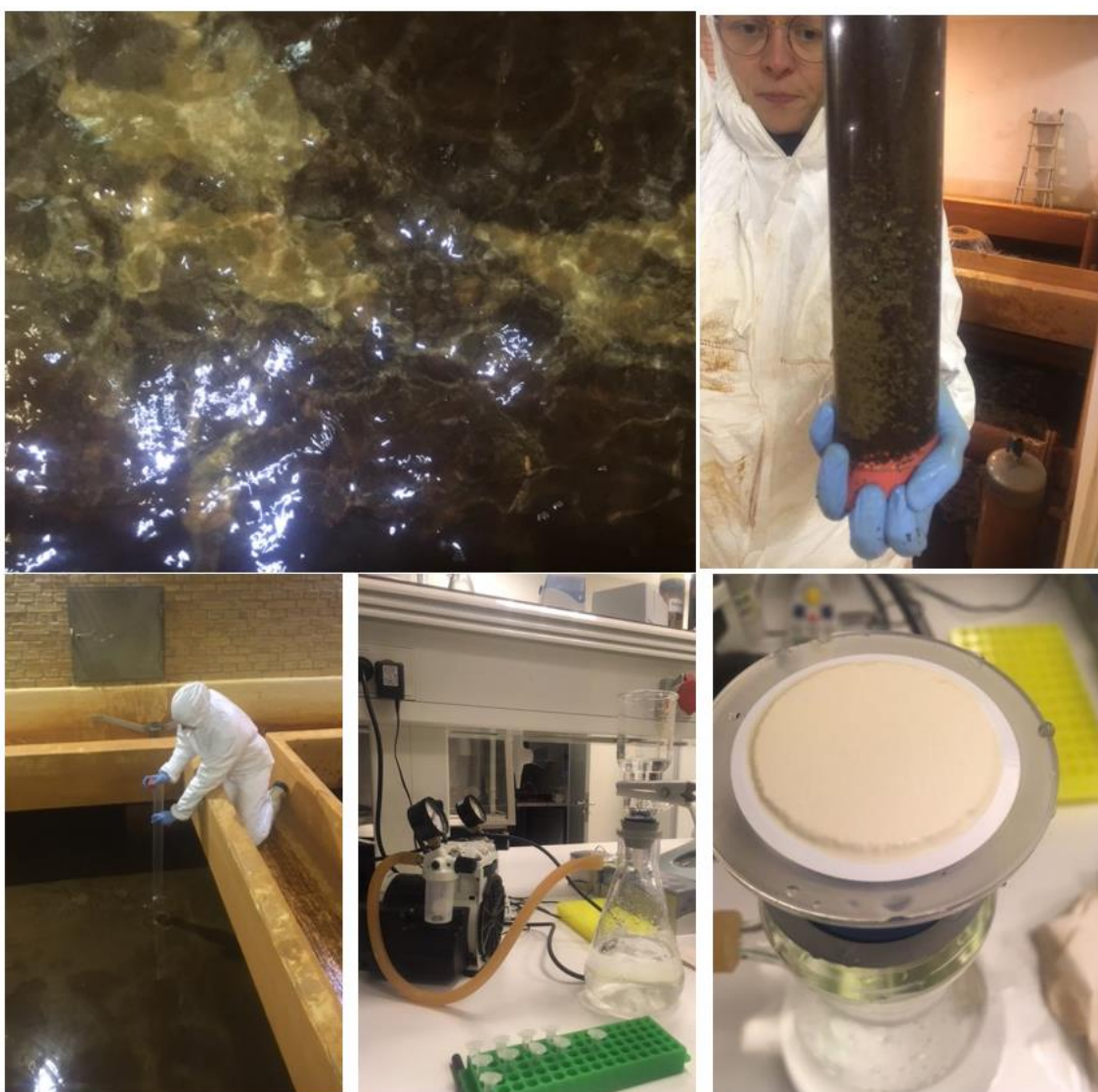
Figur 13 Fines i filtrene på Brøndbyvester vandværk. a) Hvide aflejringer på sandfiltre på Brøndbyvester vandværk, b) Fine partikler i en dybdeprofil fra sandfilter, c) Udtagning af dybdeprofil, d) Vakuumpumpe til analyse af vandprøve e) Filter med partikler fra vandprøve.
