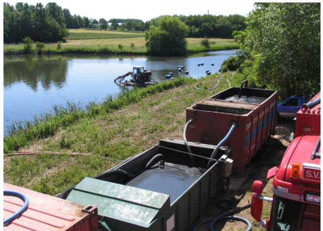
Figur 6-13: Opstilling af bundfældningscontainere
