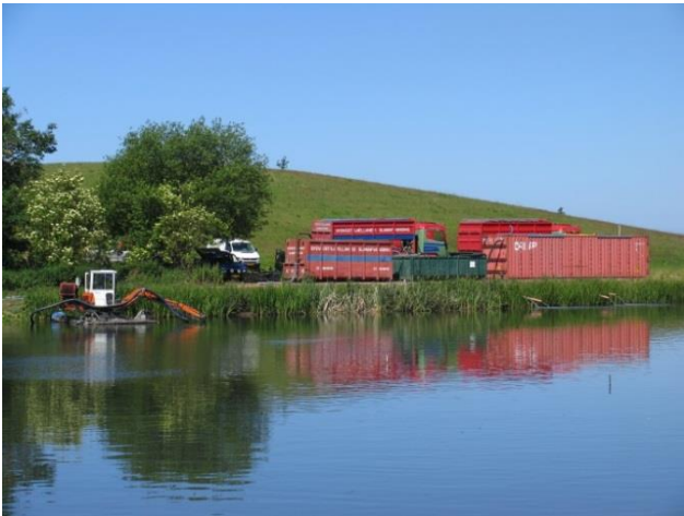
Figur 6-12 Opstilling af bundfældningscontainere
