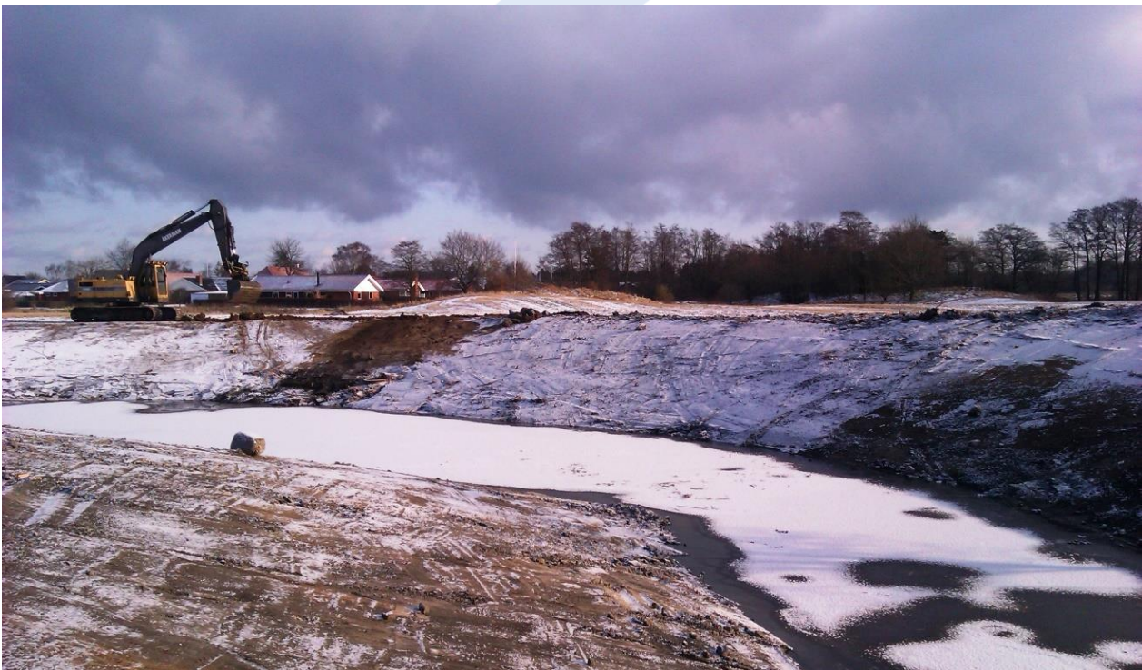
Figur 6-1: Oprensning af et bassin, Tuenvvej, Elling, Frederikshavn Kommune
