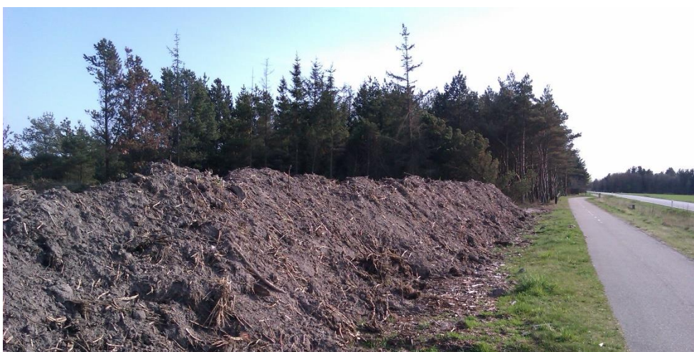
Figur 6-18: Eksempel på genanvendelse af opgravet sediment i støjvold
