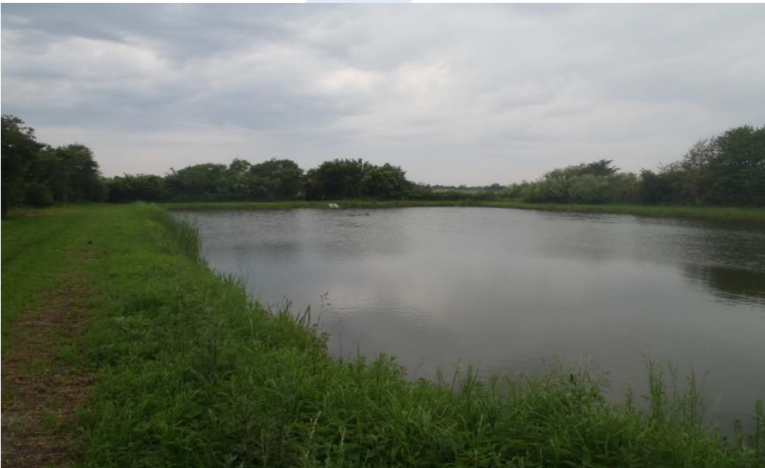
Figur 6-9 EFTER: Samme regnvandsbassin i Skælskør et halvt år efter oprensning
