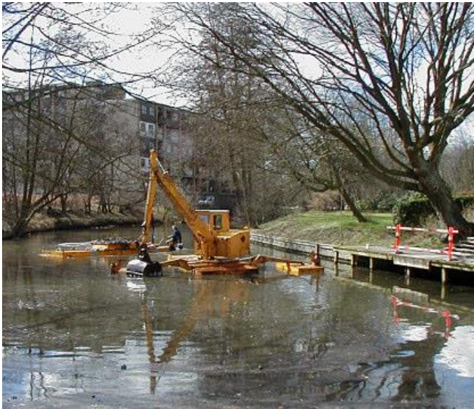
Figur 6-5: Opgravning af sediment fra vandfyldt bassin ved brug af gravemaskine på pram
