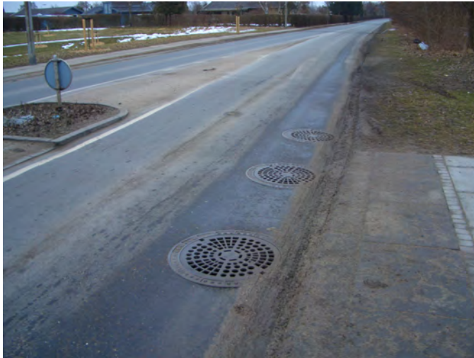
Figur B.8 Etablering af riste i vejen syd for bassin ved Mågebakken for at undgå opstuvning under ekstrem regn.
