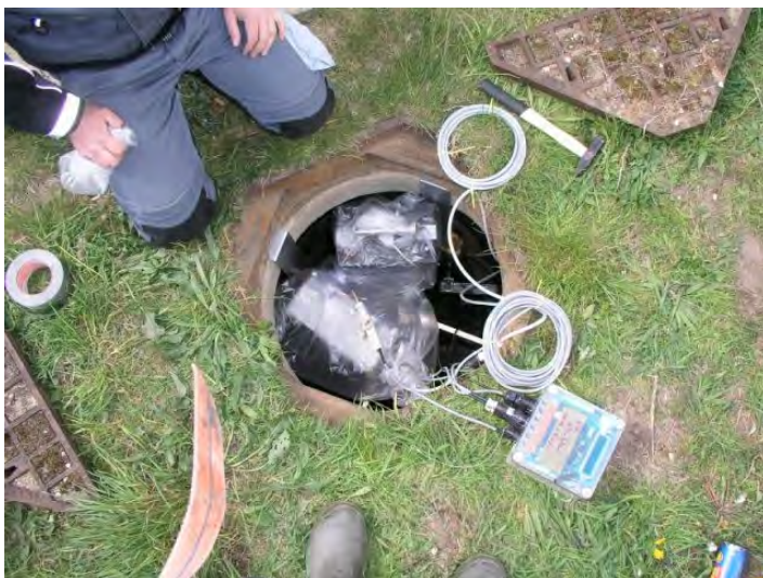
Figur F.3 Datatransmitter, batteri m.m. placeres øverst i brønden (eller i en forsejlet brøndring ved siden af målingen).
