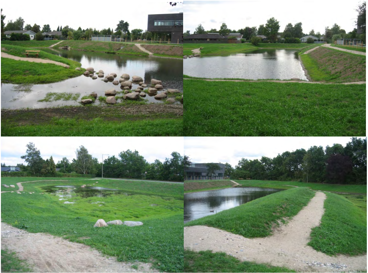
Figur B.9 Billeder af bassiner ved Mågebakken og Ejersmindevej.
