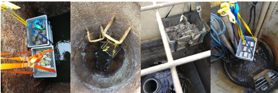
Fig. 21 Betonelementer installeret i felten ved Nørre Lyngby Renseanlæg, Vejle, Juelsminde renseanlæg og ved pumpestationen "Kildebjerget" nær Stouby (Foto fra Nørre Lyngby Renseanlæg er fra Andersen og Nielsen (2018)).
